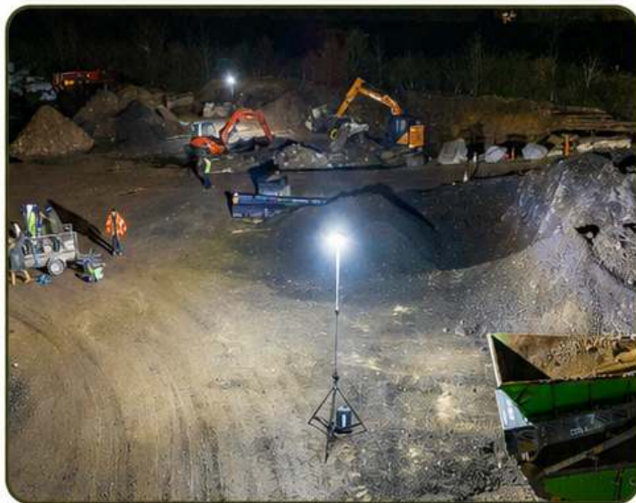
4 Aplicación operativa en obra con alta intensidad lumínica.
